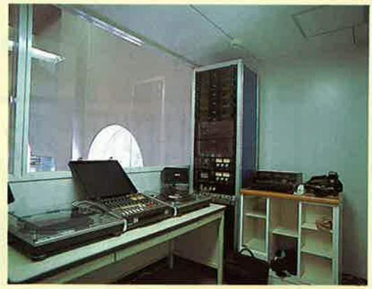
写真左 第2スタジオに設置している標準ラック型音響システム 上 第1スタジオのPAルーム 右 移動型音響システム
